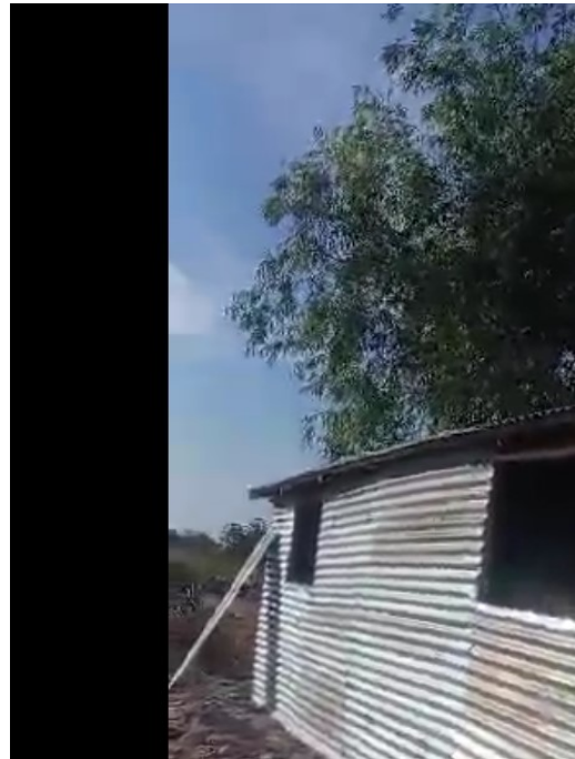
La caseta quasi acabada!
